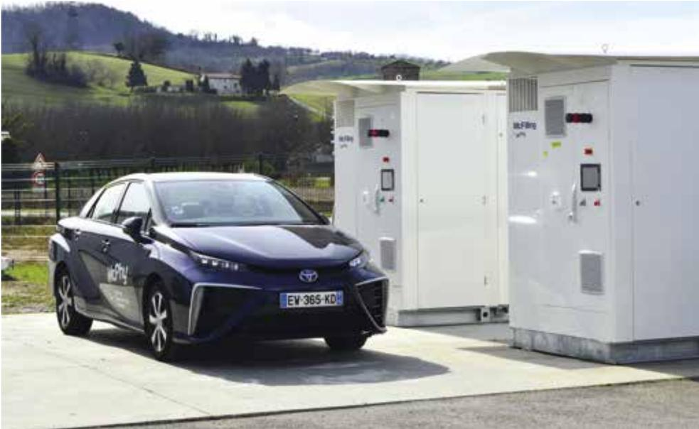
Station de recharge "McFilling" de McPhy, permettant de recharger les véhicules à hydrogène.
